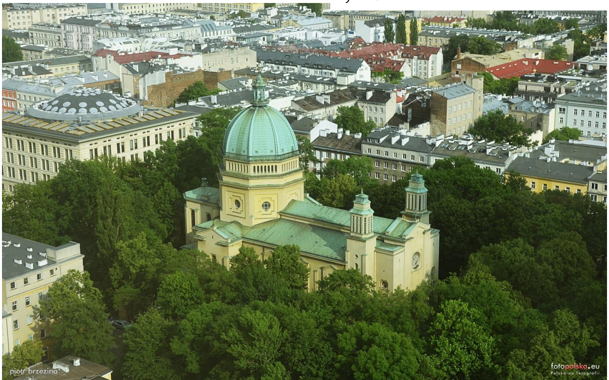
il. 27. Widok z góry na kościół pw. św. Apostołów Piotra i Pawła i część otoczenia świątyni. Fot. P. Brzezina, 2015 r.
