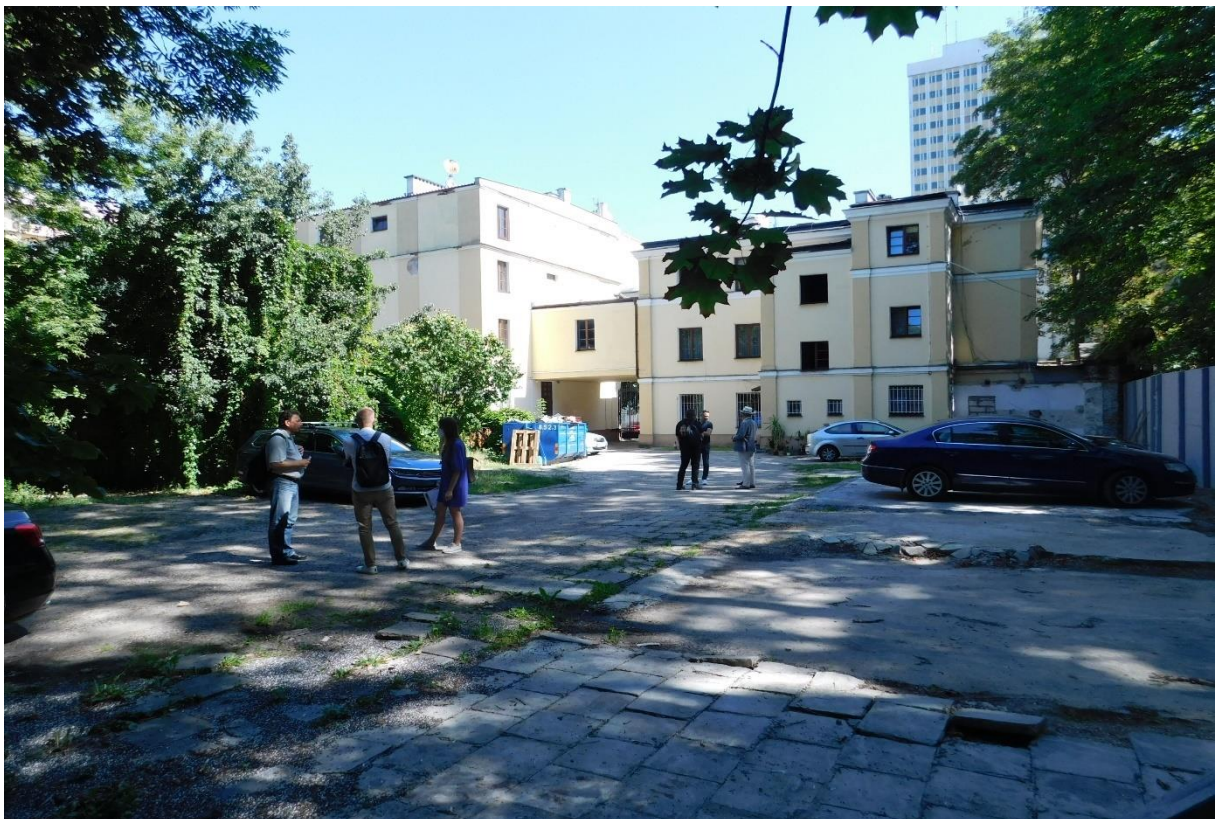
il. 24. Część terenu (działka nr. ewid. 61/1) w otoczeniu kościoła pw. św. Apostołów Piotra i Pawła. Podwórze przy budynku plebanii. Stan obecny. Widok od strony ul. E. Plater.
