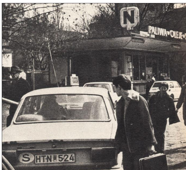
il. 19, 20. Stacja benzynowa w miejscu ogrodu u zbiegu ul. Nowogrodzkiej i E. Plater. Lata 60/70 XX w. Widać zachowaną część drzew dawnego ogrodu oraz, w tle zdjęcia po lewej stronie, część elementów historycznego otoczenia świątyni i ją samą.
