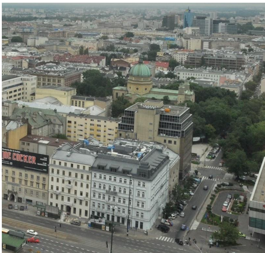
il. 4. Kościół pw. św. Apostołów Piotra i Pawła wraz z otaczającym terenem pocmentarnym w istniejącym obecnie układzie przestrzennym, wyizolowana dominanta w otaczającej zabudowie.
